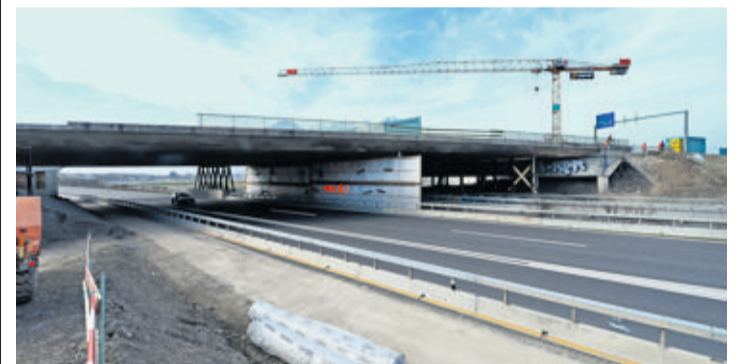
Devenu trop faible pour la charge de trafic qui l'emprunte quotidiennement, l'ouvrage doit être détruit. CHANTAL DERVEY
